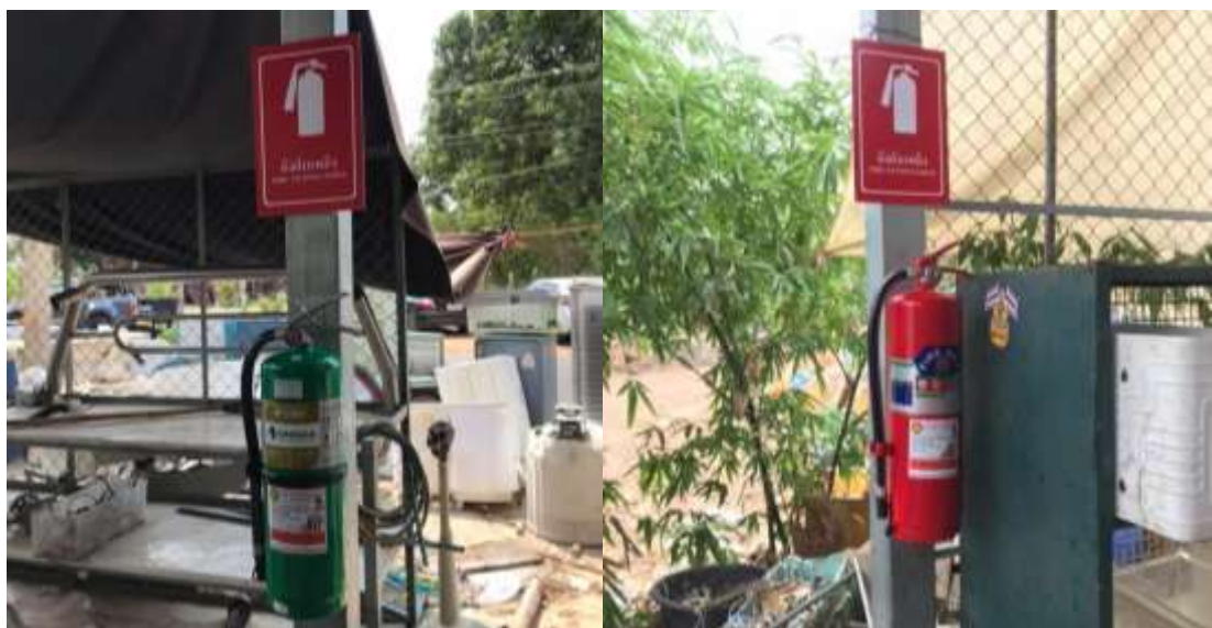
ภาพที่ 4.80 การติดตั้งถังดับเพลิงไว้สถานงาน
