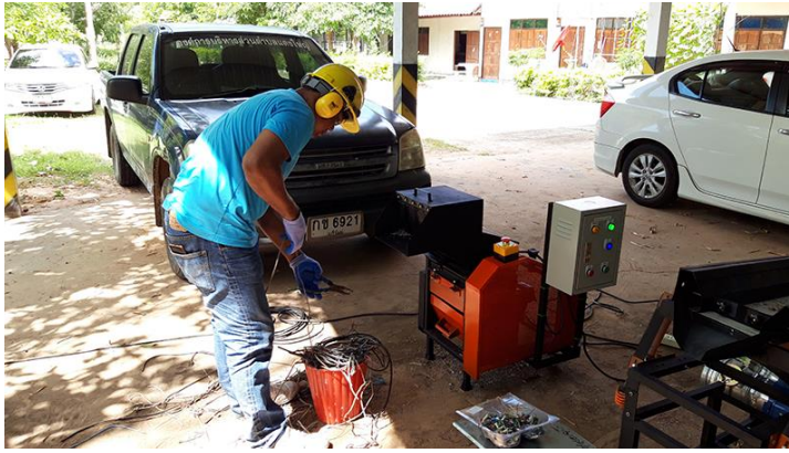
รูปที่ 4-18 การตัดเศษสายไฟฟ้า
